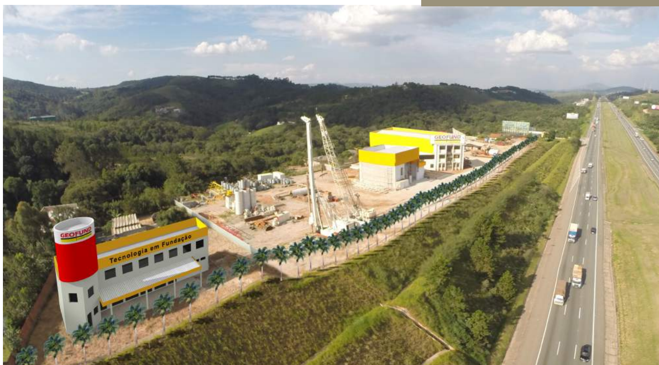
CENTRO OPERACIONAL - ITU
