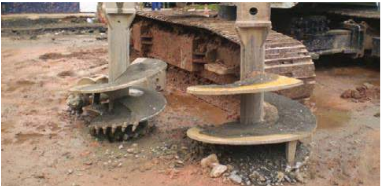
Detalhe do Trado para Rocha Detail Auger to Rock
