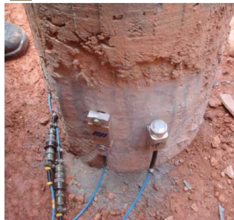
Ensaio em Estaca Escavada Bored Pile Test
